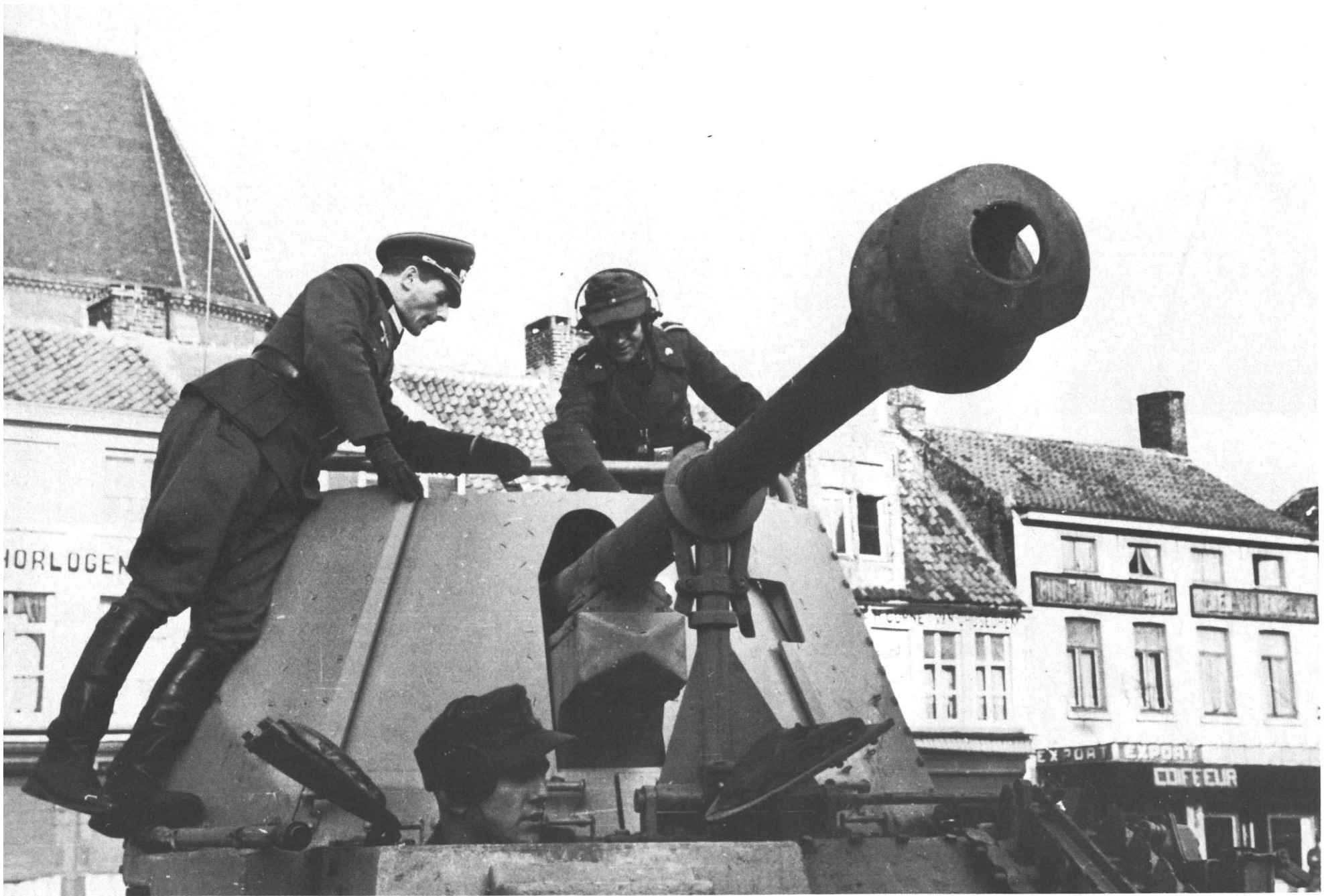
Dieses Bild zeigt gut die Marschhalterung des Rohres und die gepolsterten Innenseiten der zweiteiligen Fahrerluke – Frankreich, Mai 1944.
